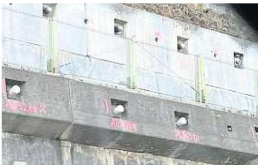
Die Ankerwände an der S6 Schnellstraße bei Leoben-Ost werden verstärkt
